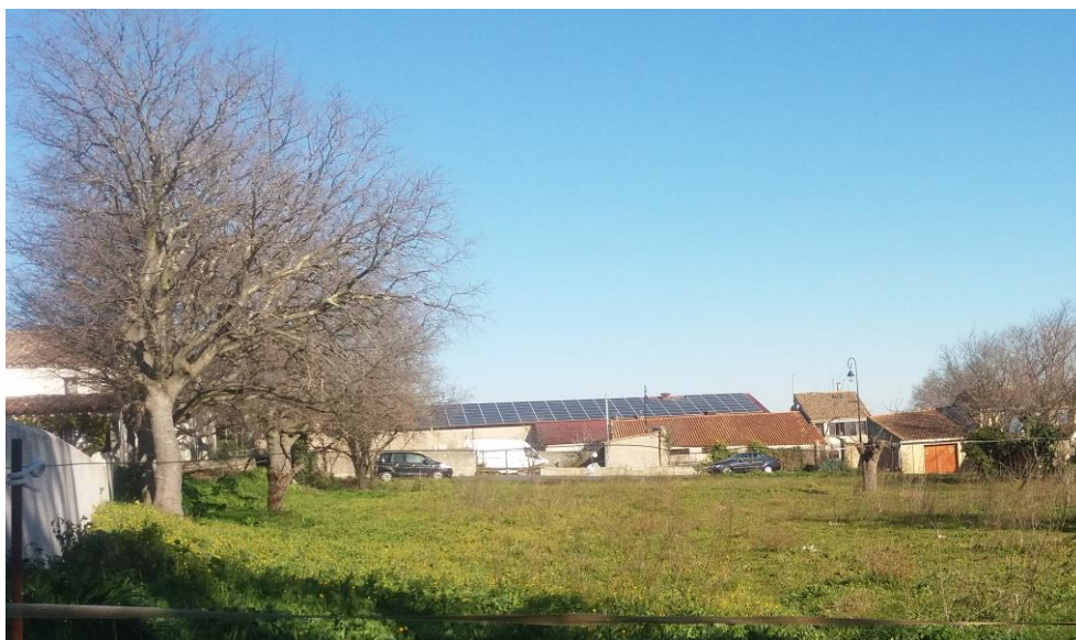
Installation photovoltaïque sur le toit de la menuiserie. Source : Verdi, 2022
