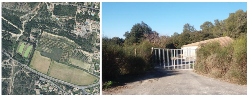
La station d'épuration et son environnement. Source : Verdi 2022, Orthophoto IGN 2018
